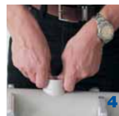
4 Helyezze a felmelegített nyeregidomot a felmelegített furatba és rögzítse kb. 16 másodpercig. Egy órával később már nyomás alá lehet helyezni, rá lehet engedni a vizet.
