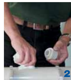
2 Tisztítsa meg. Amennyiben Stabi csövet használ, sarkítsa le a fúrt lyuk élét. Tisztítsa meg és zsírtalanítsa a hegesztőpárt, a csövet és a kifúrt lyukat.
